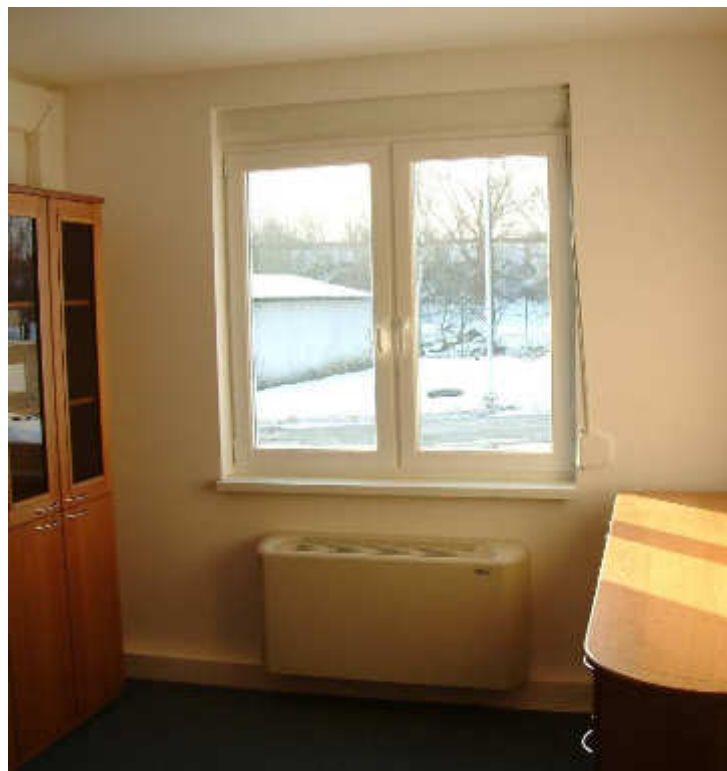
Fan coil MFU (podparapetní)
