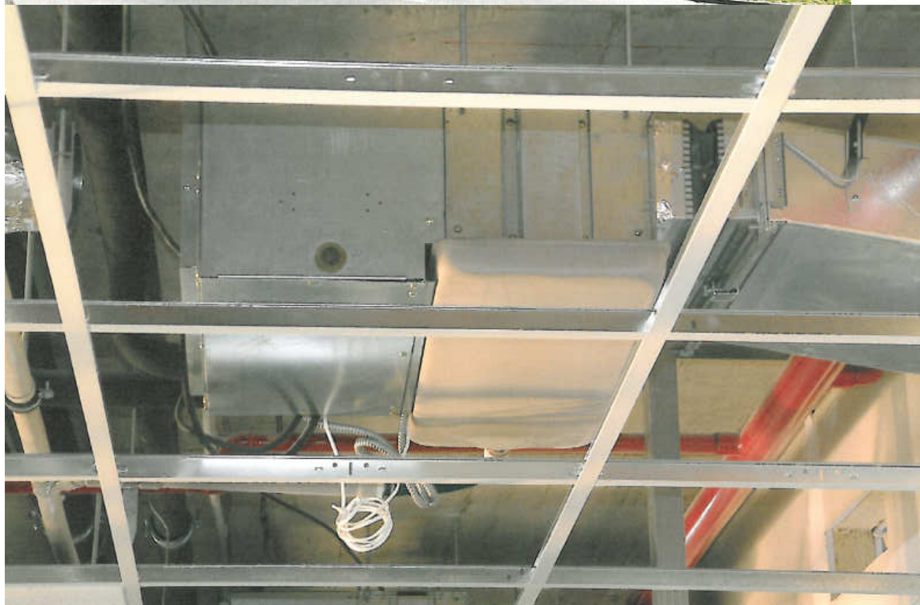
Lighthouse – fan coil McQuay MCW (kanálové)
